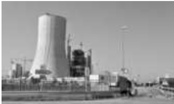
Baustelle des E.on-Kohlekraftwerks in Datteln
